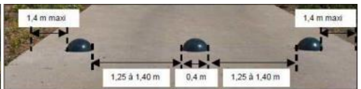
Ci-dessus : dispositif filtrant sur une voirie de largeur 5 m et plus
