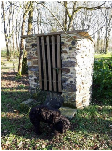
PUITS, LA BRILLERE (communal)
