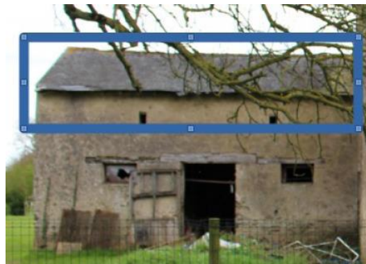
La Brillère, façade ouest (partie concernée par les chauves-souris sous les combles)
