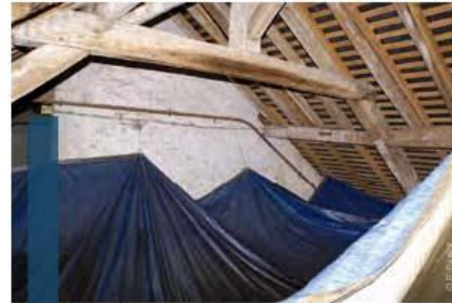
Bâches de protection dans un comble
