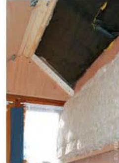
Construction d'un caisson isolé
