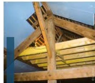
Installation d'un plancher
