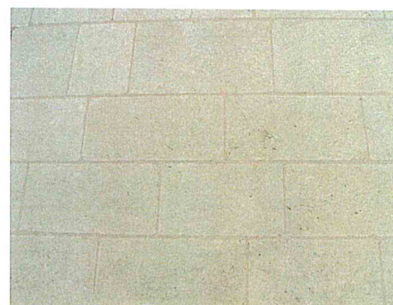
Parement de tuffeau restauré.
