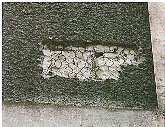
Tuffeau grillagé et enduit.
