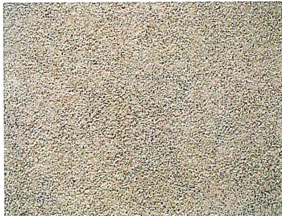
Enduit de façade à grains fins, coloré par le sable clair.
