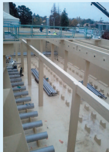
Bassin de décantation de la file BG2 en cours de rénovation.
